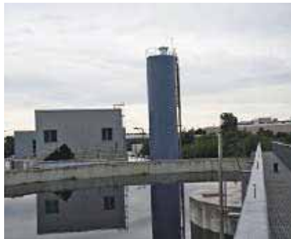
Pulveraktivkohle-Anlage auf dem Klärwerk Böblingen-Sindelfingen
