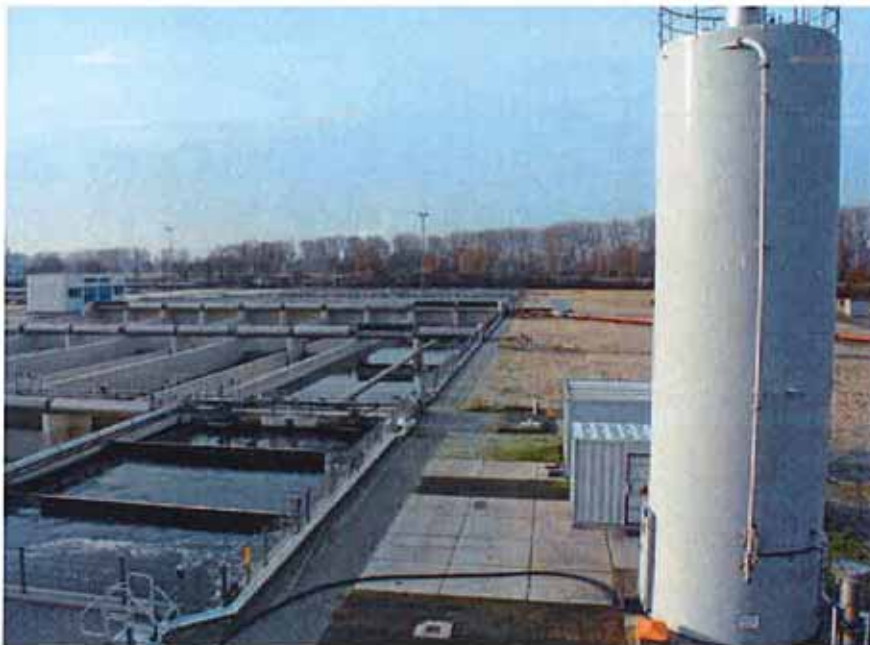
Abbildung 1: Aktuell realisierter Teil der Adsorptionsstufe im Klärwerk Mannheim
