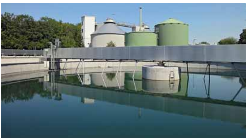
Sedimentationsbecken der Adsorptionsstufe in der Kläranlage Kressbronn
