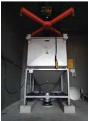
Abb. 2 Wechselcontainer für die Bevorratung der Pulveraktivkohle
